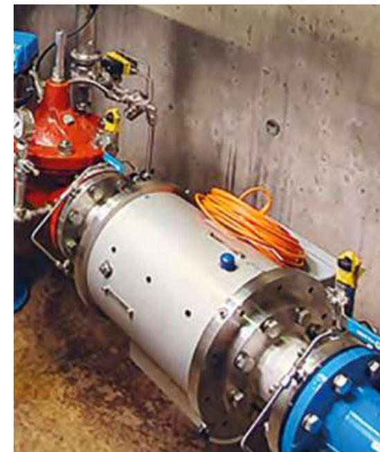
La Ville de Pully a participé à un projet pilote qui consiste à placer une turbine sur le réseau d'eau potable pour produire de l'électricité. De plus, cette installation permet de réduire la pression de l'eau, ce qui assure une meilleure durabilité des conduites.
